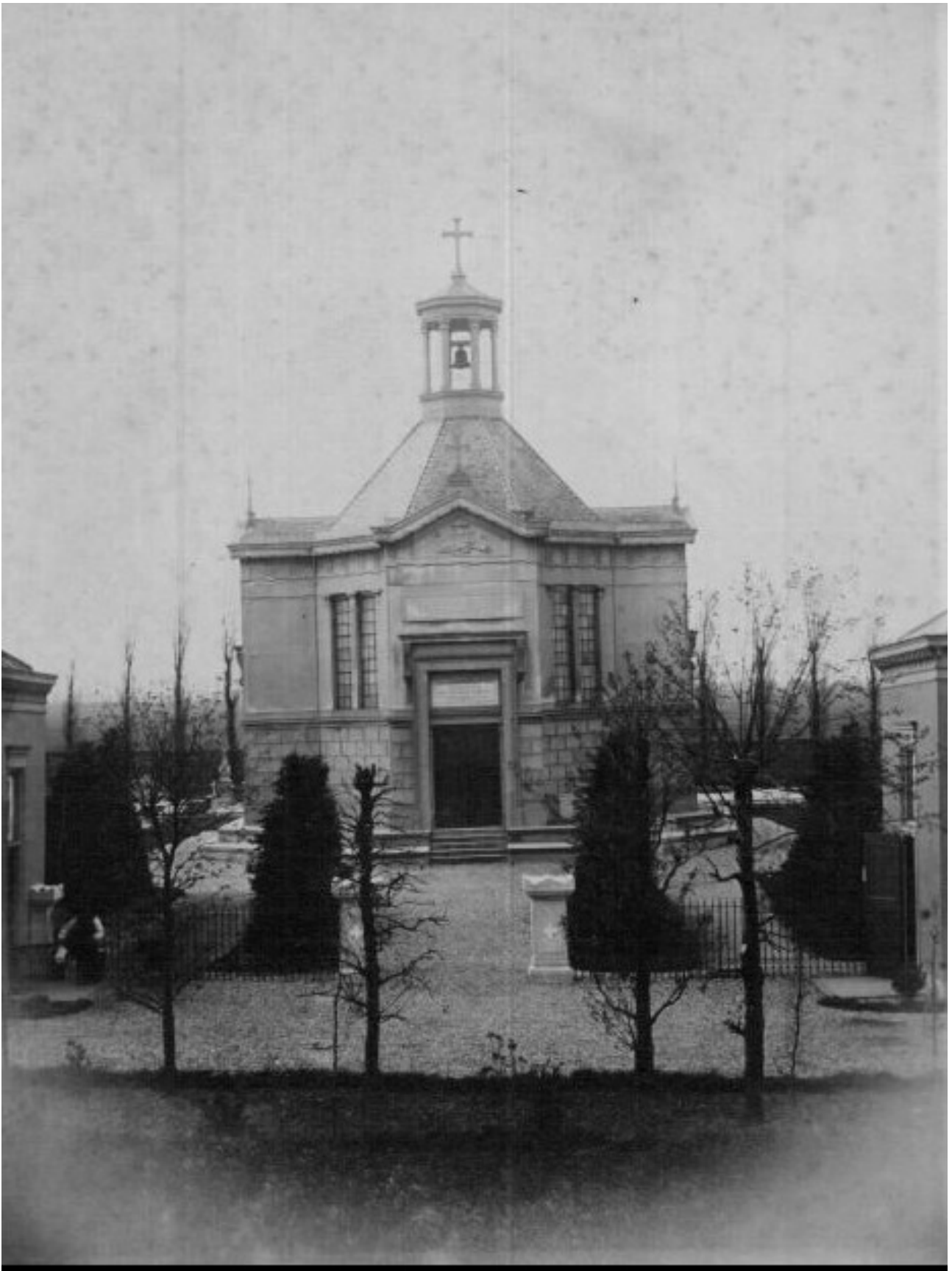
Toegang tot de RK begraafplaats (oostzijde) (1880). Aan weerszijden van de centrale toegangslaan staan twee rijen met taxusbomen in perken ). Aan de achterzijde (west) wordt de begraafplaats besloten door een rij Italiaanse populieren of gekandelaberde essen. De paden zijn bestrooid met grind (foto: beeldbank GA Schiedam, beeldnr. 09672).
