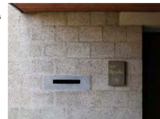
Afb. 16: De wanden van ‘Huis Naalden’ zijn opgetrokken uit grote bimsbetonnen B2-blokken van 29 x 19 x 19 cm. Muur naast de hoofdingang van het huis met hardstenen brievenbus, betonnen latei boven de deur en ongeschaafd vurenhouten plafond (foto Arjan Bronkhorst)
