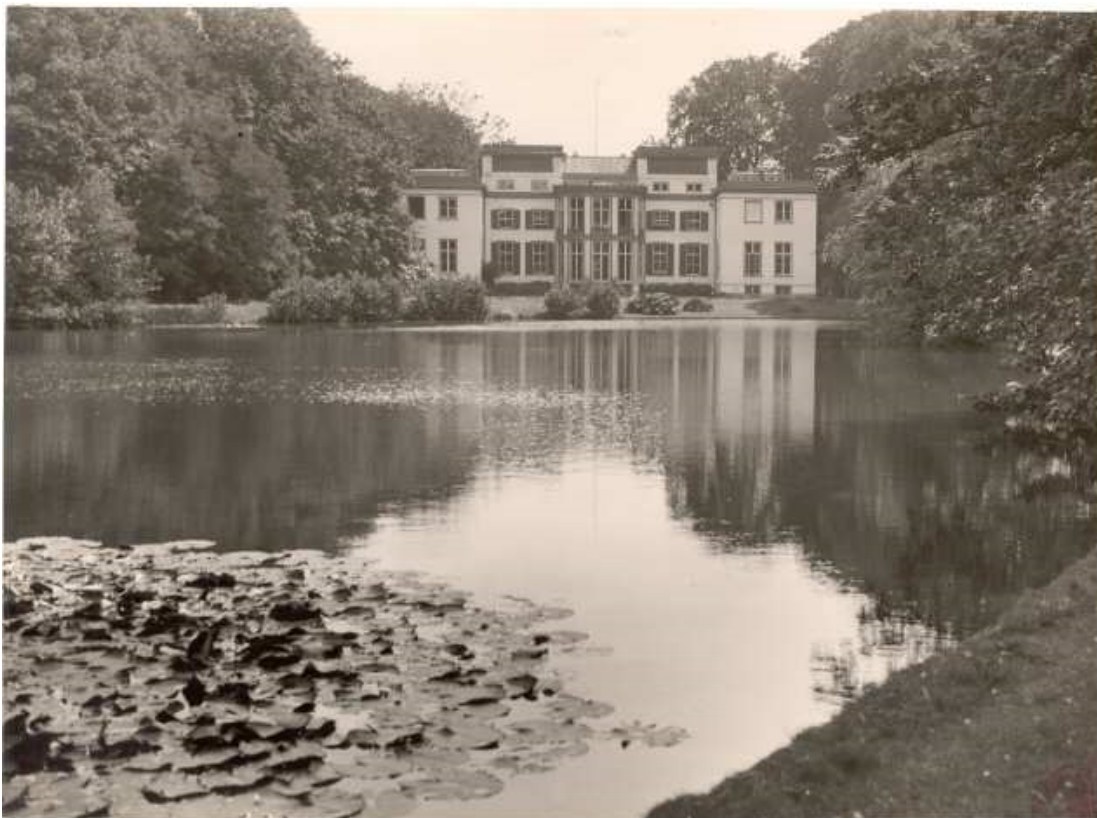
Achterzijde Huis de Paauw te Wassenaar, met aangebouwde vleugels, en vijver en rododendronpartijen achter het huis
